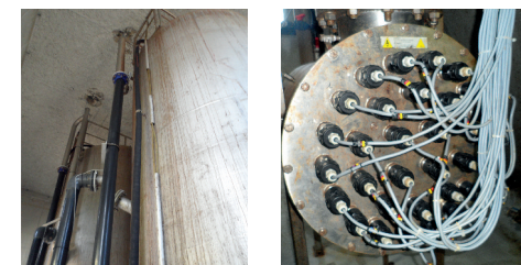
Traitement tertiaire + refoulement sur 4 km pour une capacité maximale de 2500 m 3 /j Exploitation en Délégation de Service Public : de l'ordre de 1,5 j de travail hebdomadaire en période d'irrigation ; 690 Wh/m 3 [données Véolia]
