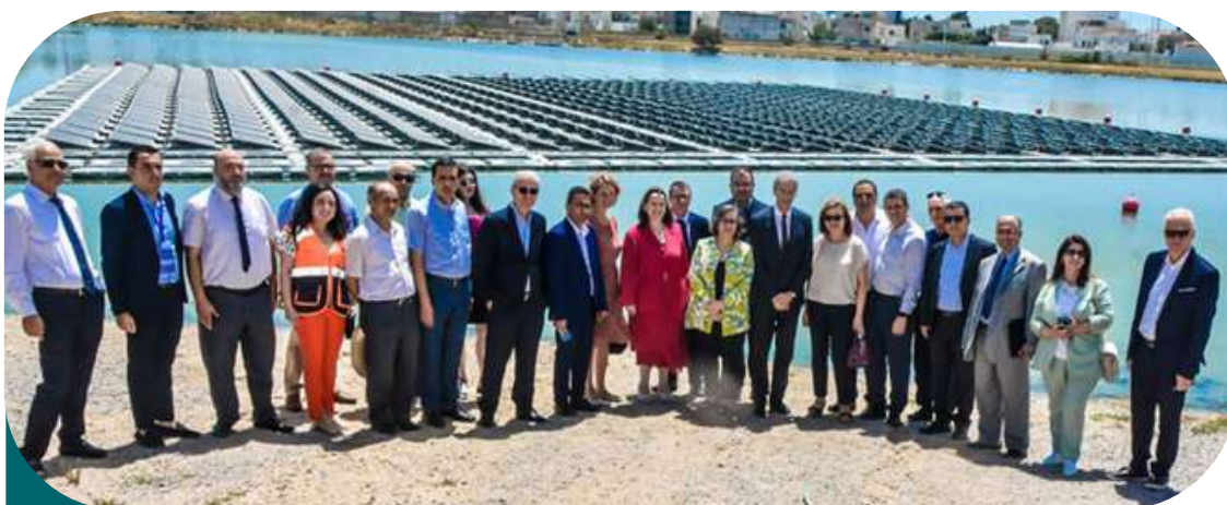
Figure 1. Centrale solaire flottante sur le lac de Tunis. Source : Kapitalis.com
