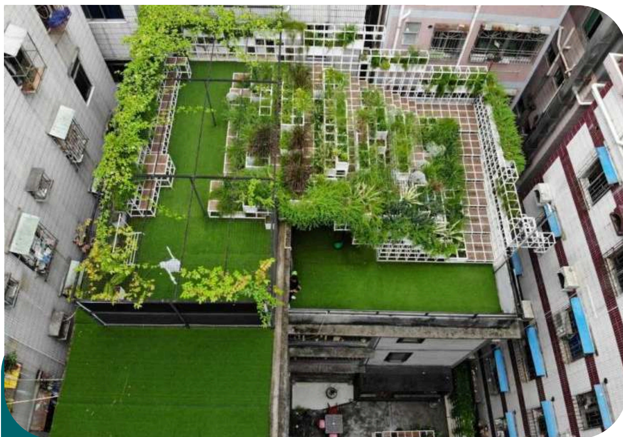
Vue aérienne du projet Green Cloud à Gangxia. Source : Qiang & Yu (2020) .
