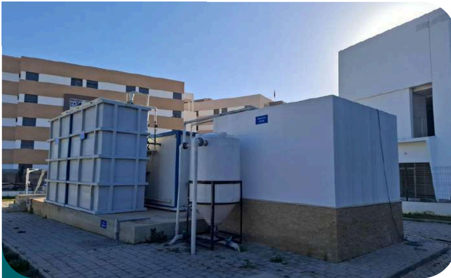
Figure 1. Vue extérieure du Living Lab de la station d'épuration de l'UIT. Source : Université Ibn Tofail
