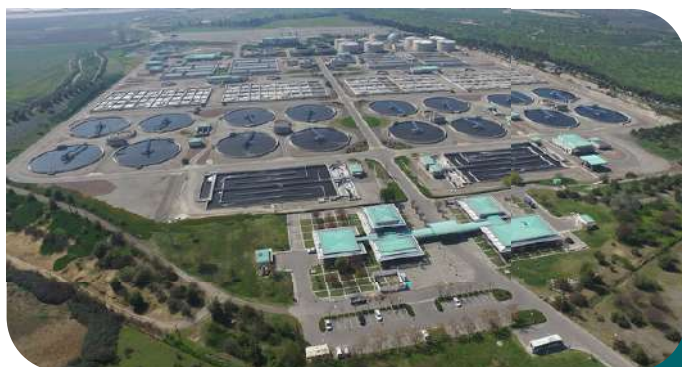
Vue aérienne de la bio-usine La Farfana. Source : ohstgo.cl (n.d.).
