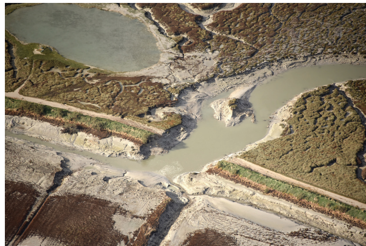
Dans la Baie de Lancieux en Côte d'Armor, le sentier littoral est interrompu en 2022 par une brèche sur la digue de front. Dans le cadre de la mission Adapto, un nouveau tracé de grande valeur est envisagé à l'intérieur des terres. Photo Erwan Le Cornec
