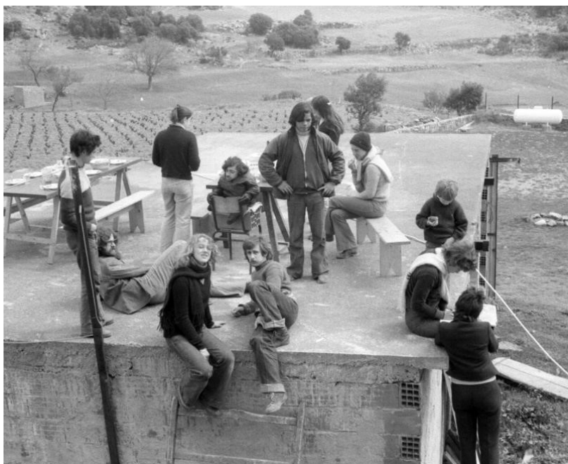
L'atelier et la cuve à gaz, aux abords immédiats du prieuré en 1975 photo S. Foillard
