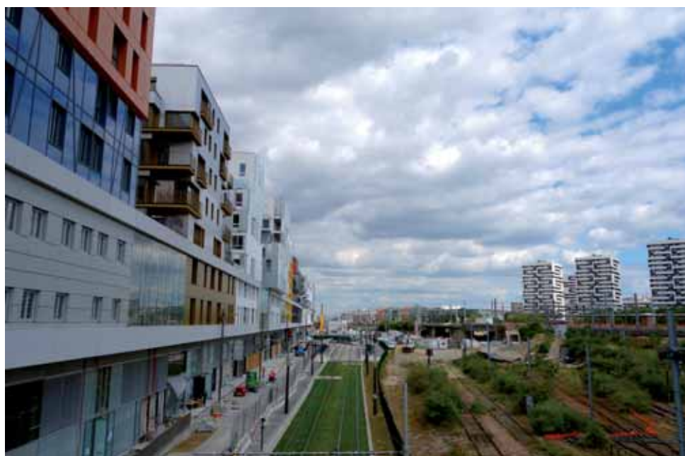
Projet Paris Nord-Est. Réhabilitation des entrepôts Mcdonald.
