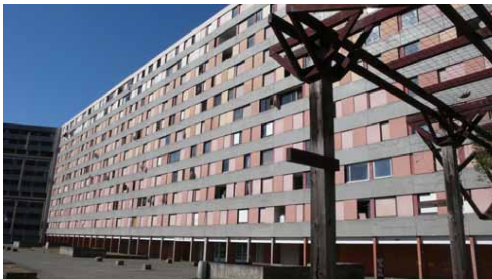
L'immeuble Concorde avant sa démolition
