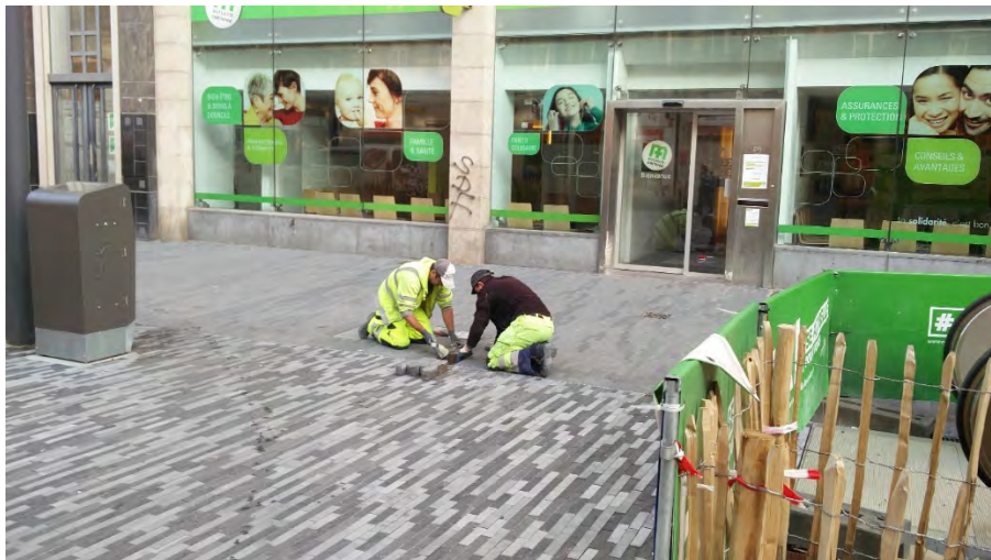
Fig.6 : Réfections en cours sur le piétonnier.
