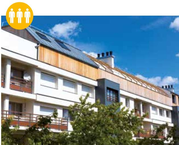
Une rénovation complète d'un immeuble de 78 logements a été réalisée rue de Tlemcen à Paris : la partie existante du bâtiment a été transformée (agrandissement des séjours, création de patios) et une surélévation d'un étage a été réalisée pour créer 6 logements supplémentaires.
