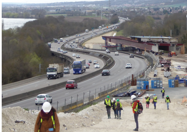
Voyage-atelier Le Mantois en 2100. Visite du chantier du viaduc de Guerville, 2018. photo Joséphine Billey, école nationale supérieure de paysage
